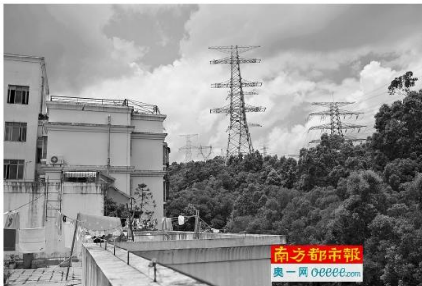
高压电塔矗立在翠雅居小区紧邻处。南都记者陈文才 摄
